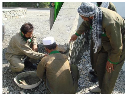
Auch beim Mauern wird immer wieder nachgemessen.
